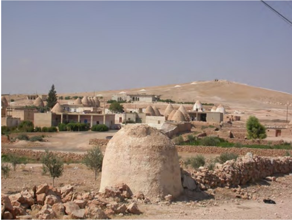
Abb. 35: Oberirdischer Speicherbehälter aus Lehm in Syrien (Bartl 2004, Abb. 7.200)
