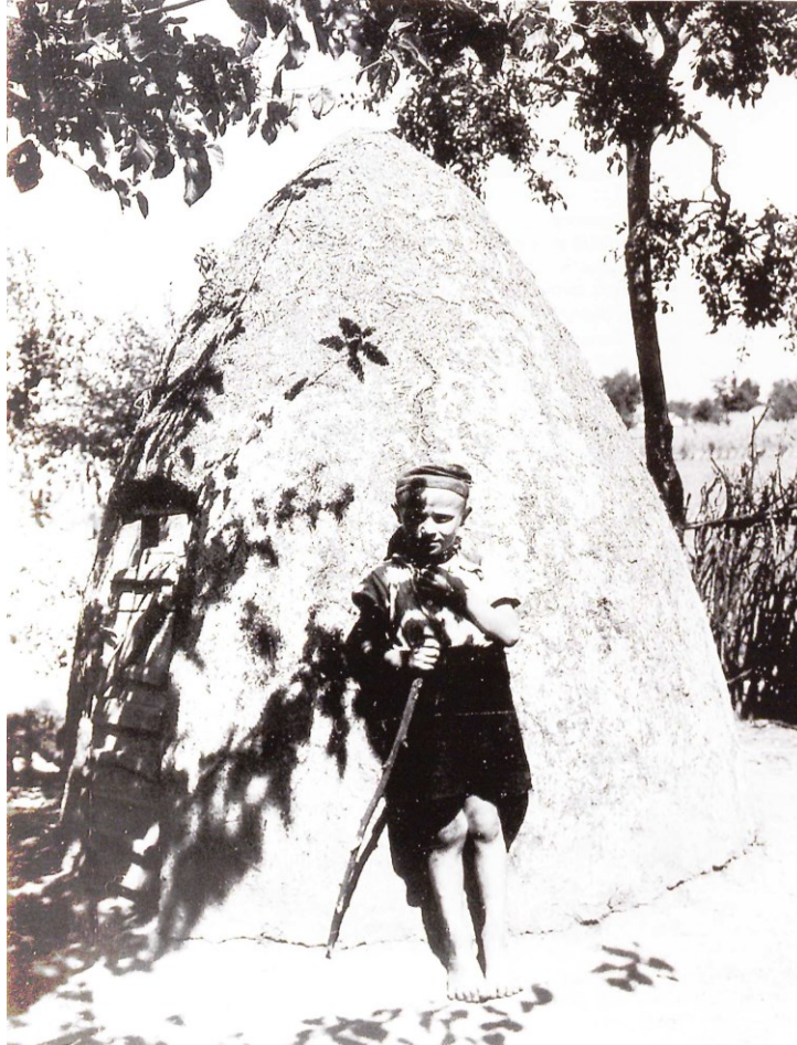
Abb. 34: Oberirdischer Speicherbehälter aus Karcag (Kom. Jász-Nagykun-Szolnok, Ungarn). (Aufnahme 1956) (Kunz 2004, 69).
